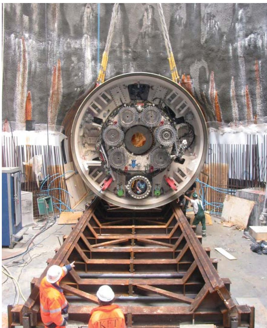
Figur 4.16 Samling af TBM i startkammer, KE Fjernvarmetunnel (København 2006).
