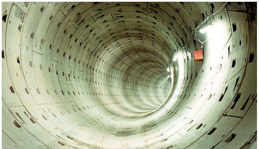
Figur 4.4 Tunnelrør beklædt med præfabrikerede betonelementer; Københavns Metro.
