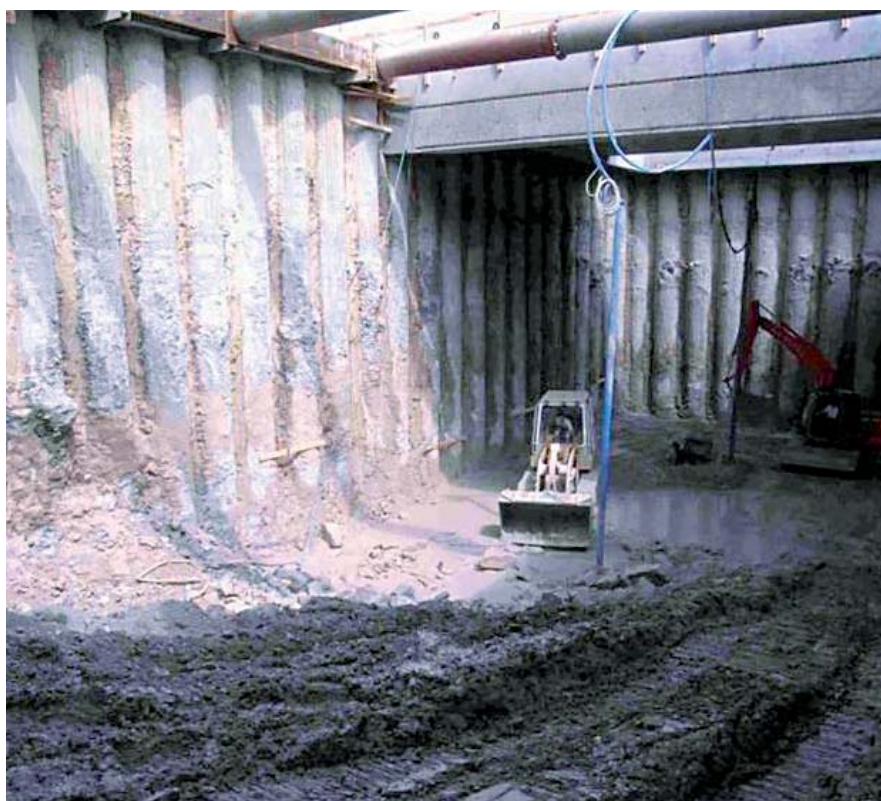
Figur 4.13 Udgravning af stationsboks mellem primære støttevægge udført med sekantpæle i armeret beton, Københavns Metro.
